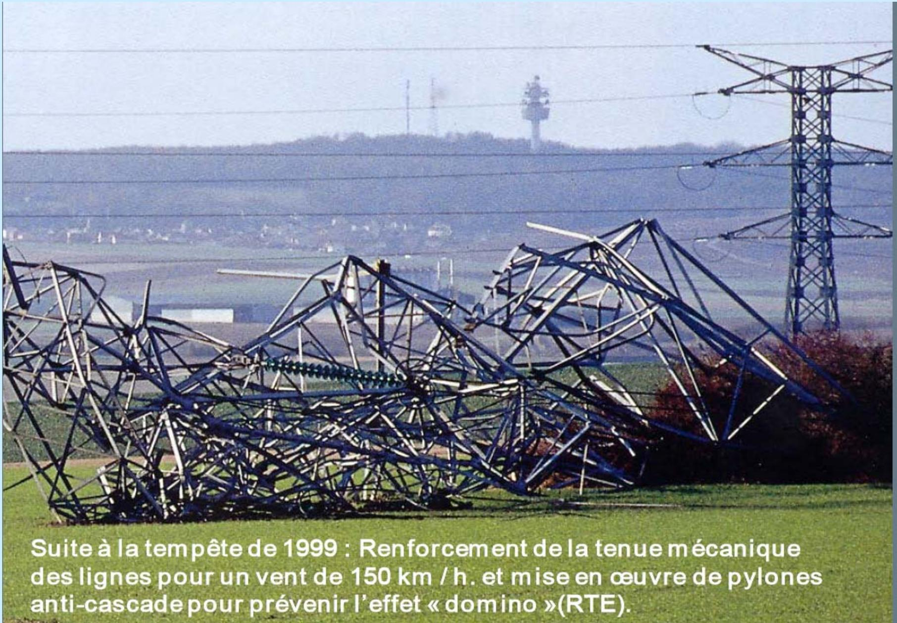
Suite à la tempête de 1999 : Renforcement de la tenue mécanique des lignes pour un vent de 150 km / h. et mise en œuvre de pylones anti-cascade pour prévenir l'effet « domino »(RTE).
